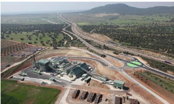
**Figura I:** Planta de biomasa perteneciente a **ENCE ENERGÍA EXTREMEÑA, S.L.**, situada en Mérida, con una capacidad instalada de 20 MW de electricidad mediante el procesamiento de biomasa agrícola y forestal.
